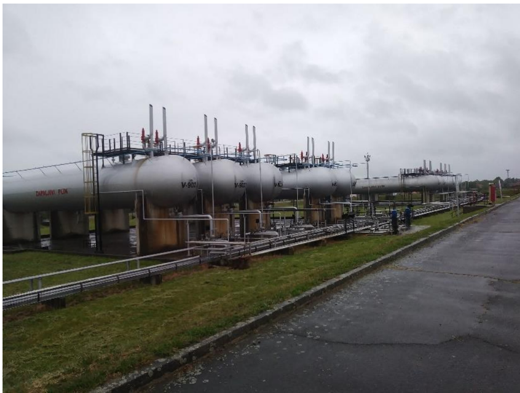
Slika 14: Rezervoari Butana Izvor podataka: OFIG
